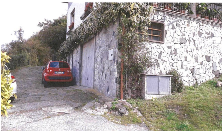
Illustrazione 2: l'accesso dalla strada
