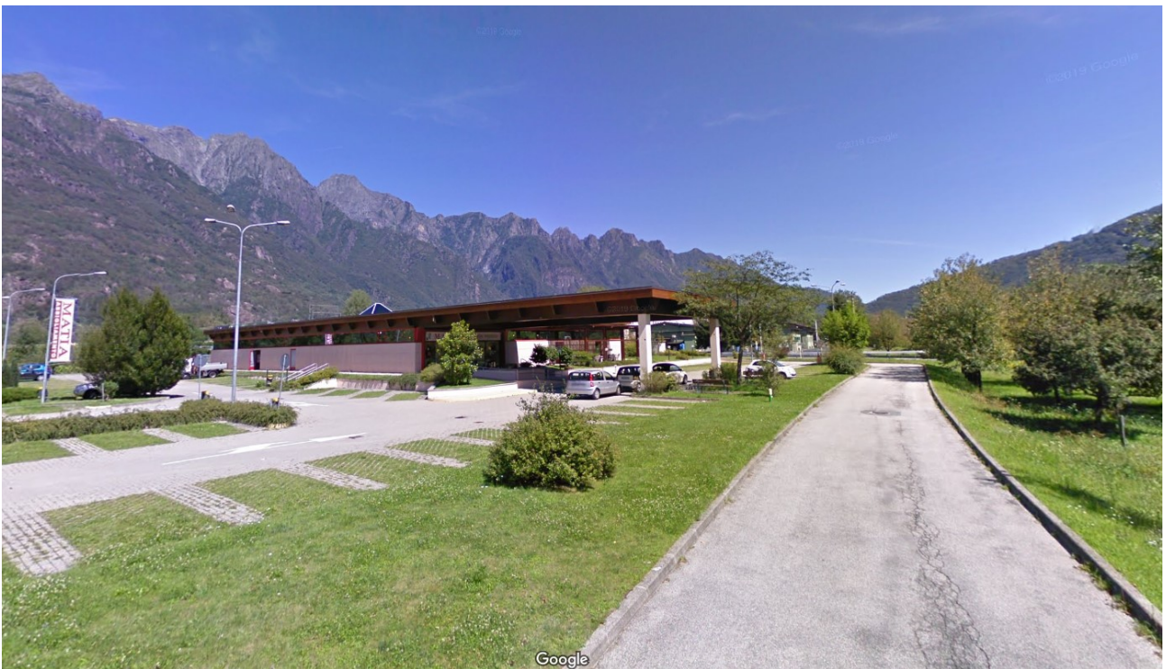
Immagine 2 – Vista prospettico sud-ovest del capannone dalla strada comunale
